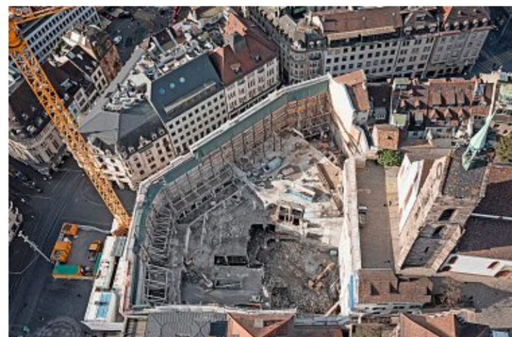
Ein Loch in Basel: Dort soll ein Globus-Warenhaus hin. Foto: Dominik Plüss
